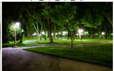
<가로등 설치로 야간시야 확보>
